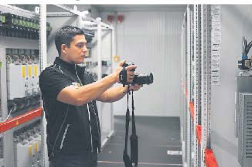
Prüfheld bei der Elektrothermografieprüfung: Hohe Qualität und Zuverlässigkeit zeichnen die Dienstleistungen aus.
